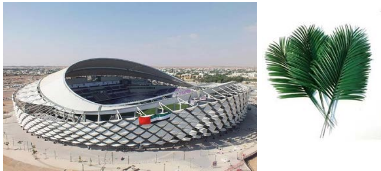
Şekil 10. Hazza Bin Zayed Stadyumu cephe malzemesi (URL-10) ve doğadan esin kaynağı hurma yaprağı
